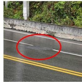
ก่อนดำเนินงาน
