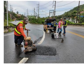
ขณะดำเนินงาน
