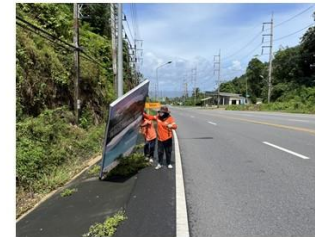
ขณะดำเนินงาน
